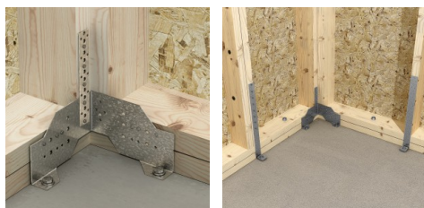
Liaison des murs d'ossature sur dalle béton
